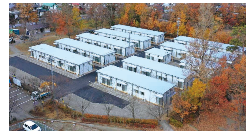
応急仮設住宅
